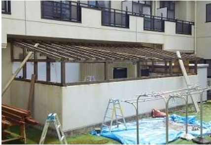
↑ 屋根を外した状態
